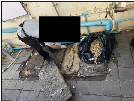
รูปที่ 3-32 ขุดลอกตะกอน ถังดักไขมัน และทำความสะอาดท่อระบายน้ำ
